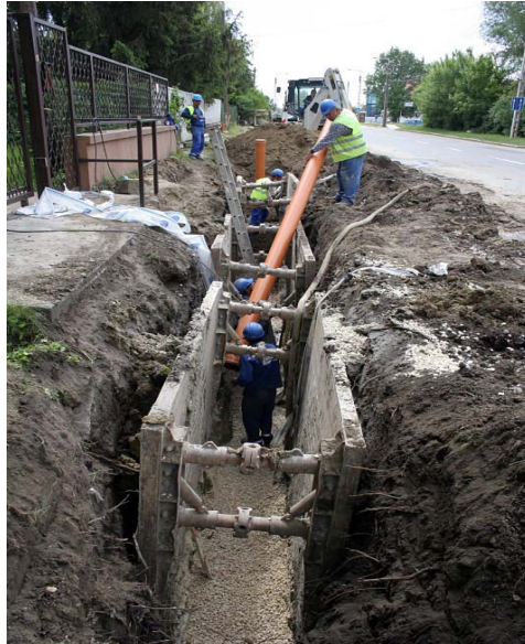
7.ábra: Csatornacső fektetése
