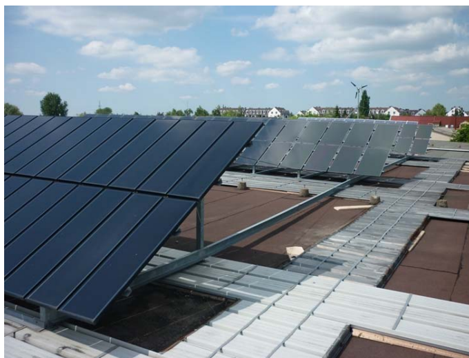
1. ábra. A napelemek elhelyezése a tetőszerkezeten Kyocera KC 120 w, Siemens ST 40w, Dunasolar DS 40w
